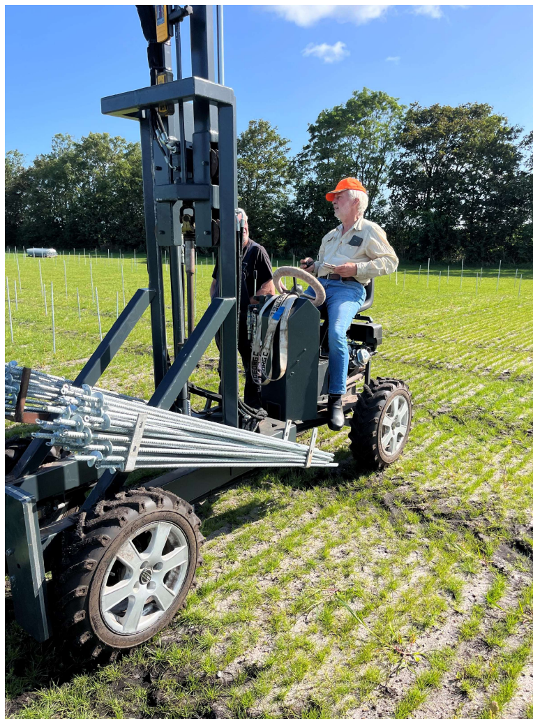
Hydraulisk ”iboringsmaskine”, som betjenes af en chauffør og en montør. Knækstyret, som altid muliggør præcis iboring
