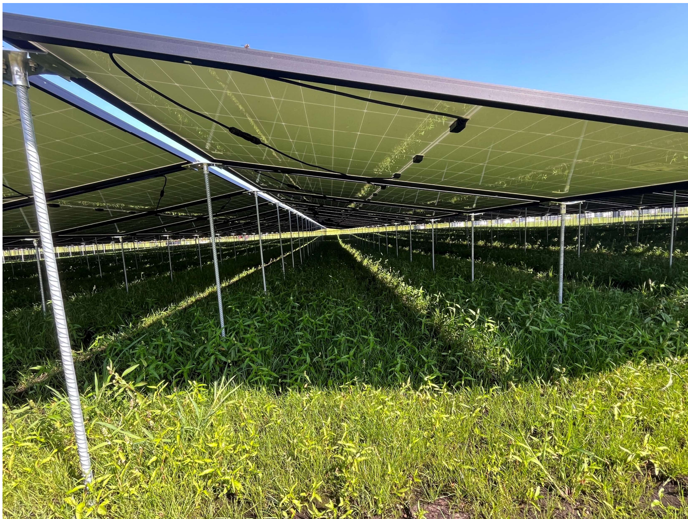
Montagen i "portræt" gør det muligt at spare mange meter DC-kabel og letter montagen. Kabler strippes fast under panelerne.
