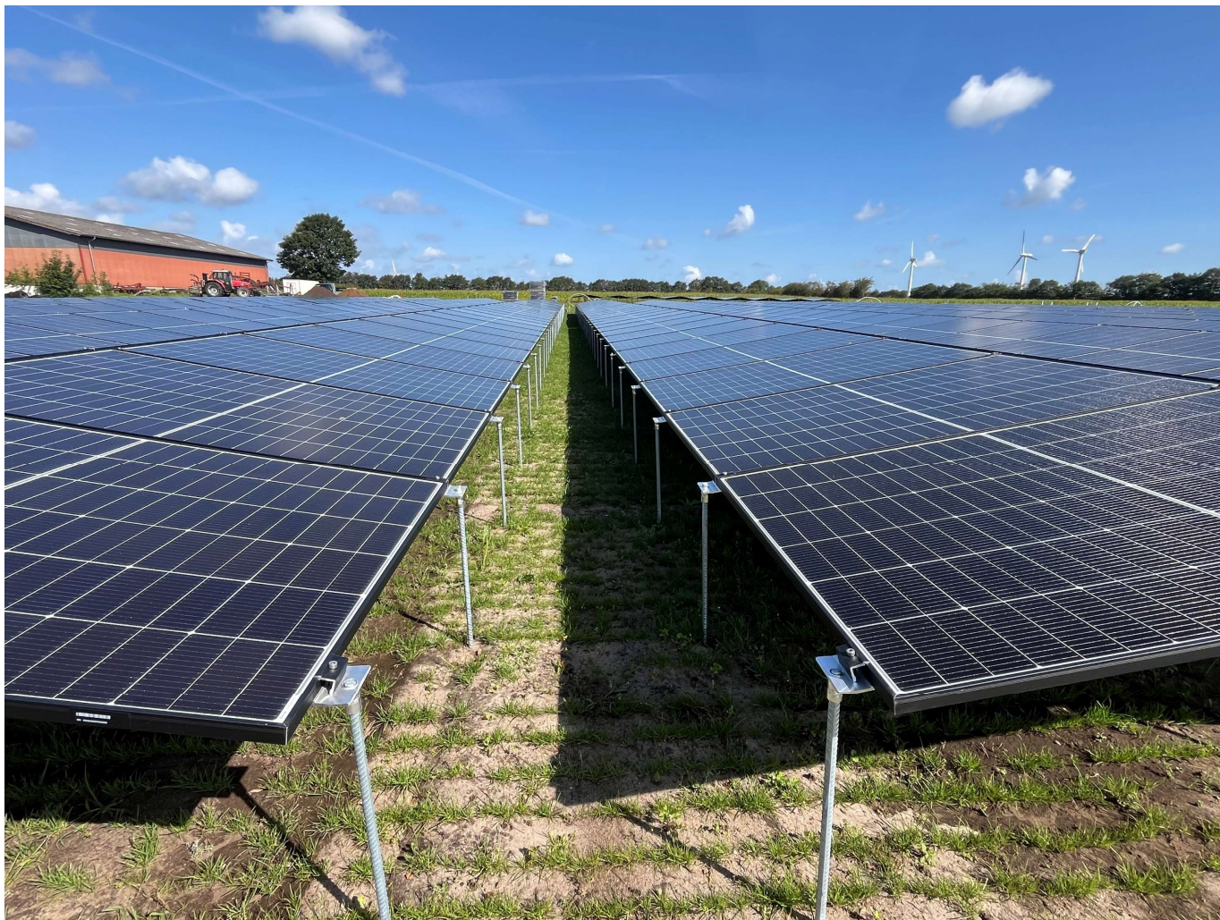
Der etableres 60 cm bredt gangareal mellem de 21 solcelleblokke
