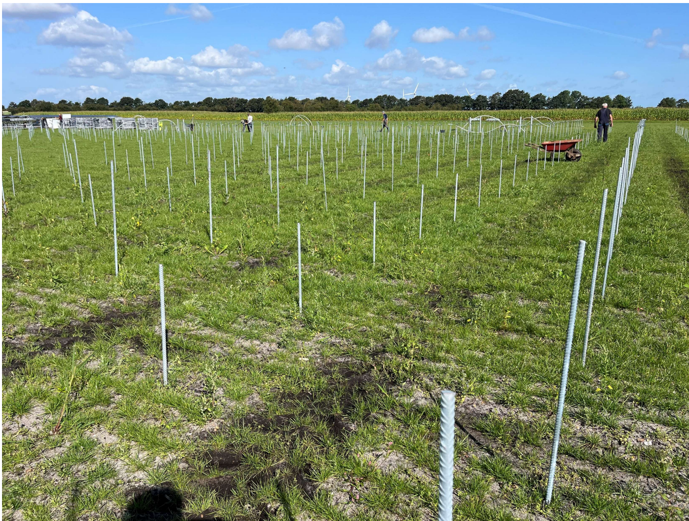
Projektet starter med præcis itrykning af galvaniserede stålpæle ved anvendelse af laser.
