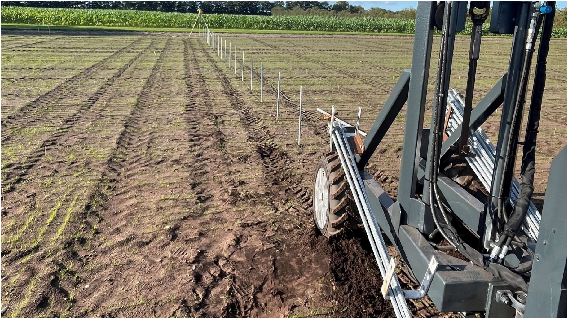
Arealet oprilles med GPS-støtte og der isættes blomsterpinde i alle kryds for isætning af stålpæle
